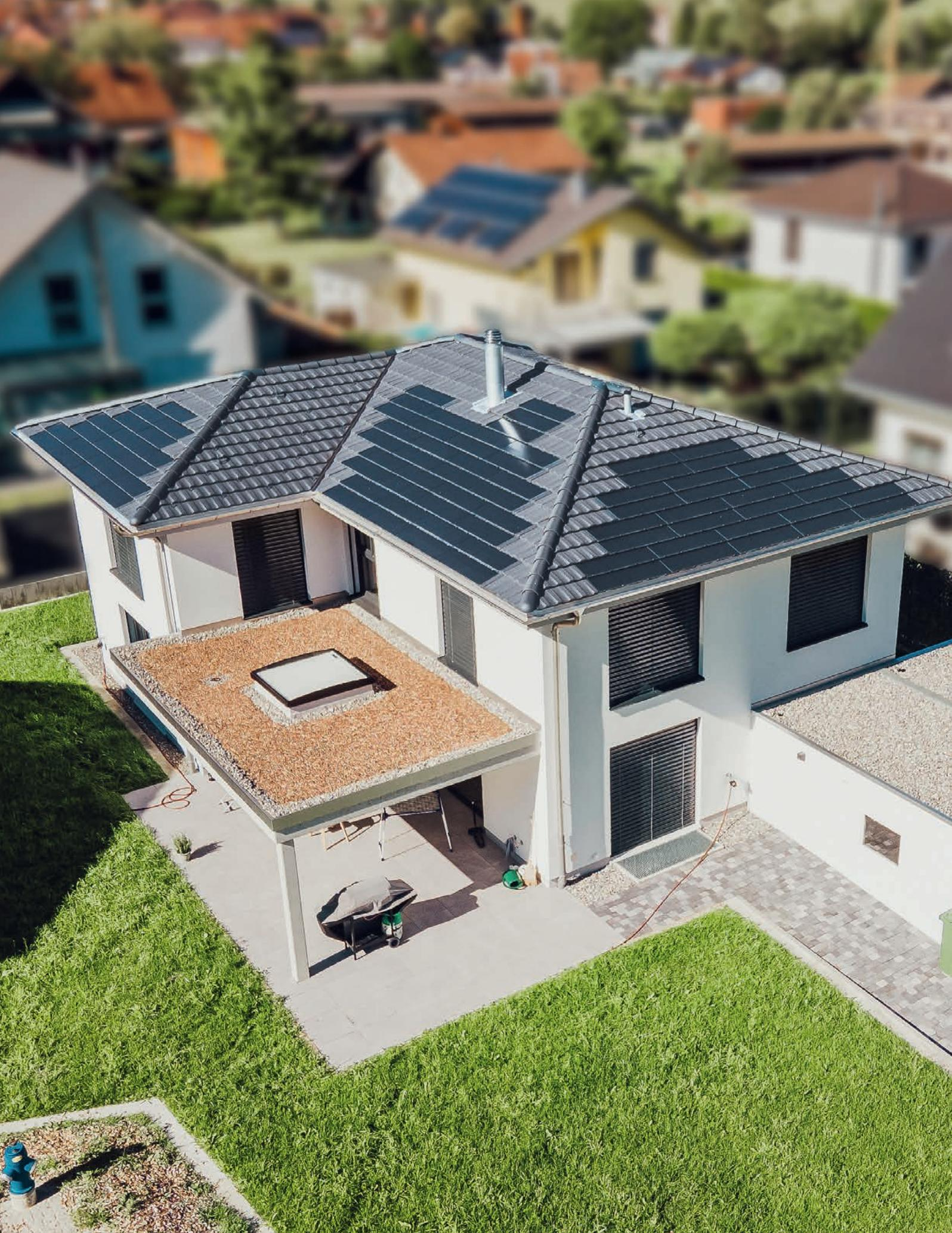
Das Walmdach des neuen Einfamilienhauses eignete sich dank flacher Neigung (19 bis 23°) und freistehenden Dachseiten (Nordost, Südost und Südwest) optimal für die leistungsstarke und harmonische Kombination aus Photovoltaik-Modulen MAX und FS37 Flachschiebeziegeln.
