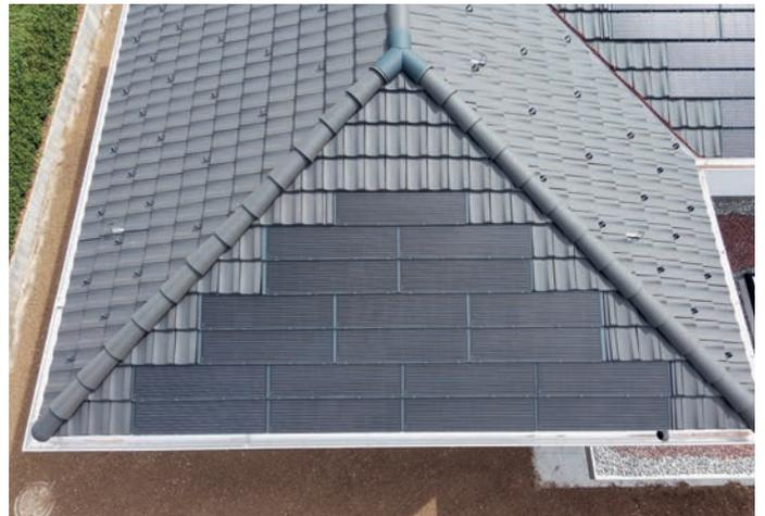
Optimal genutzte Fläche auf der Südwestseite: Die Integration der Photovoltaik-Module MAX ist bis fast an die Gratziegel möglich. Dank eines angepassten Rahmens fügen sich die Panels ästhetisch in das Gesamtbild aller Dachziegelfamilien oder in eine Schieferdeckung ein.
