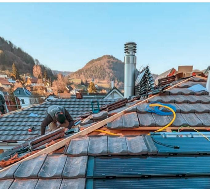
**Enge Platzverhältnisse: Die Dachdecker mussten die gesamten Grat- und Kehlanschlüsse vorgängig erstellen, da ein nachträgliches Eindecken aufgrund der kurzen Distanzen zur Photovoltaik-Anlage nicht möglich war.**
